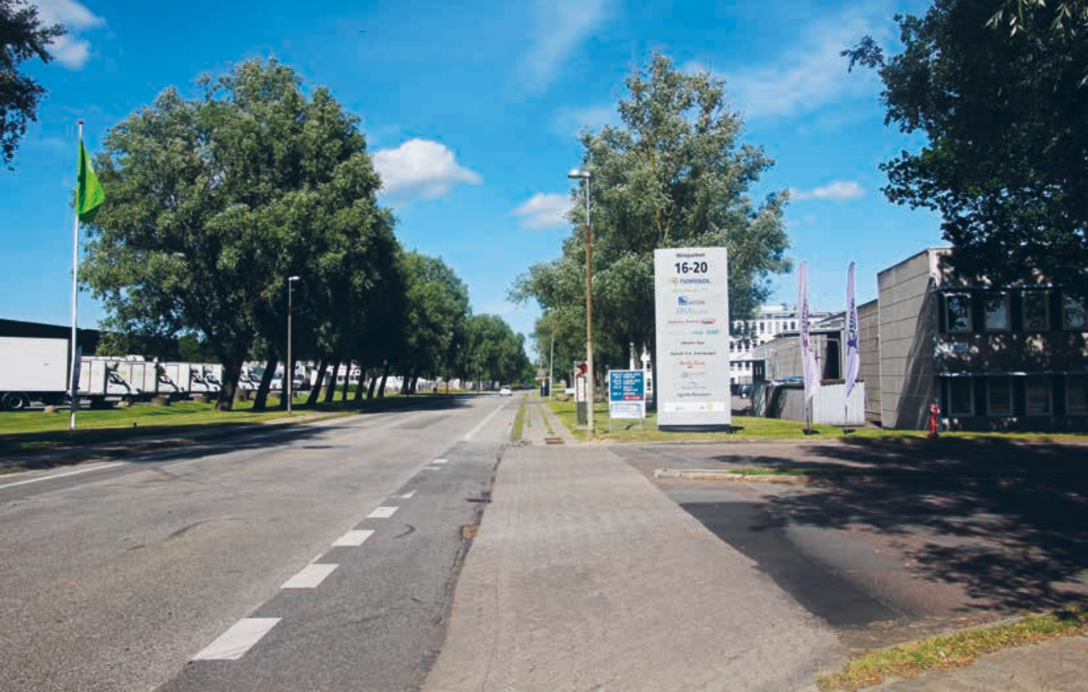
Midtager, Brøndby Kommune. Den brede overkørsel er nødvendig af hensyn til tunge køretøjs arealbehov. Hvis trafikken til/fra en ejendom ændrer sig markant i forbindelse med en ny afvigende funktion, bør store og brede overkørsler ombygges, så de bliver mindre og mere overskuelige. Foto: Via Trafik
